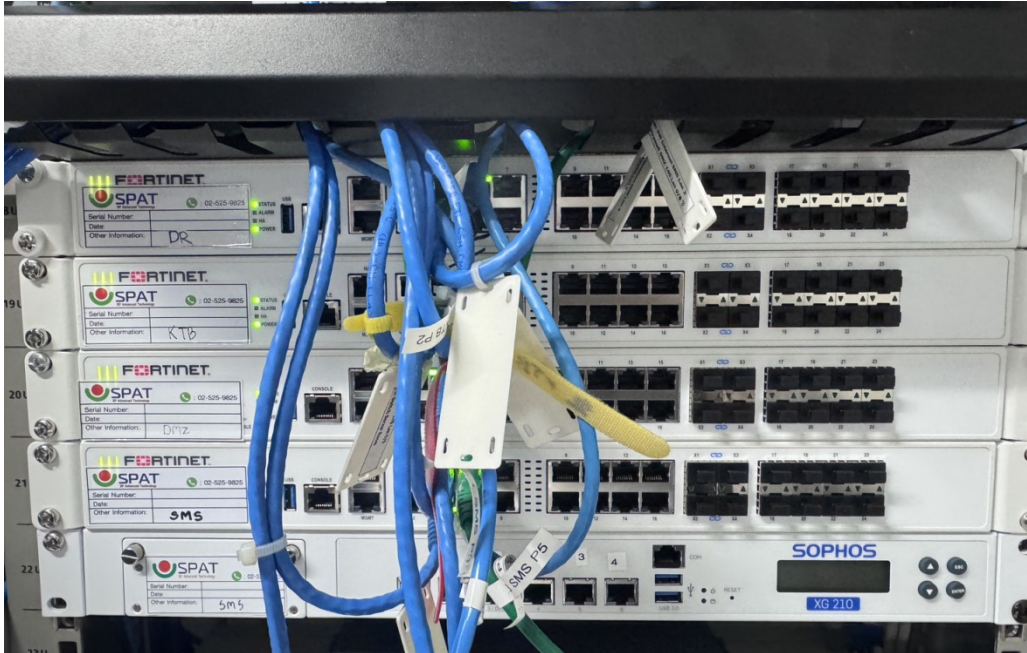
ภาพที่ 2.2 อุปกรณ์ป้องกันการบุกรุก Firewall ของสหกรณ์
